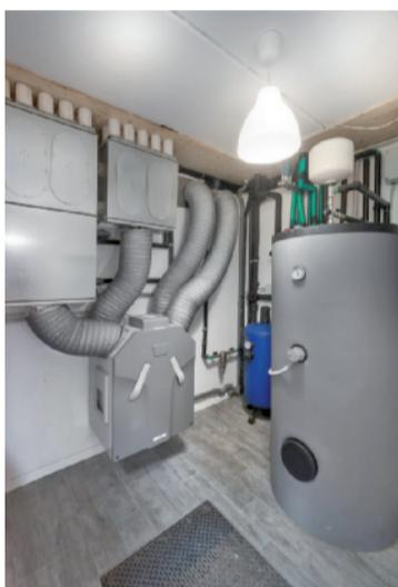
**IL LOCALE TECNICO** situato nel piano interrato dove convergono gli impianti elettrici e termici: accumulo di 500 litri per l'acqua calda sanitaria, collettori e testine della pompa di calore esterna, sistema di ventilazione meccanica.
