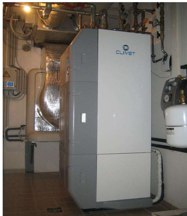
GAIA, che integra in sé i principali elementi dell'impianto, incluso l'accumulo sanitario integrato da 200 litri e tutti i collegamenti per il solare termico, che contribuisce alla produzione di acqua calda sanitaria in maniera gratuita.
