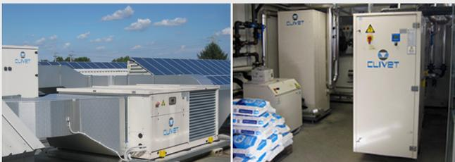
Conè - Sistema ZEPHIR di rinnovo aria a recupero termodinamico e pompe di calore acqua-acqua nella centrale termofrigorifera dell'ipermercato
