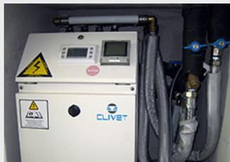
Complesso della Torre - Scambiatori oceanotermici in acciaio al titanio e pompa di calore acqua-acqua ad alta efficienza a servizio di un appartamento
